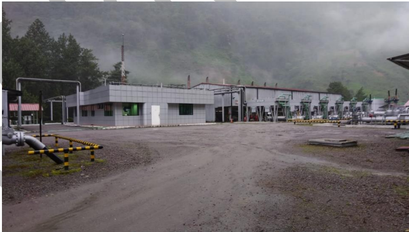
Fotografía 30. Estación de Bombeo Baeza
