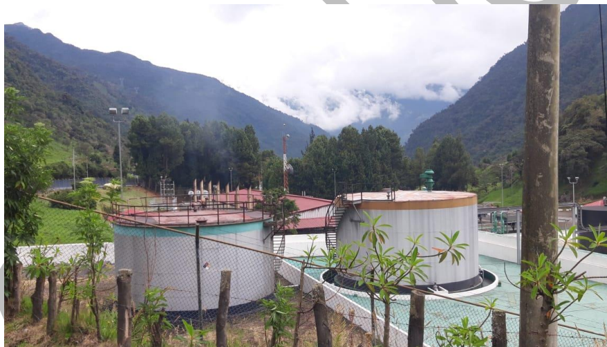
Fotografía 4. Fuente de contaminación por Hidrocarburos- SOTE Papallacta.
