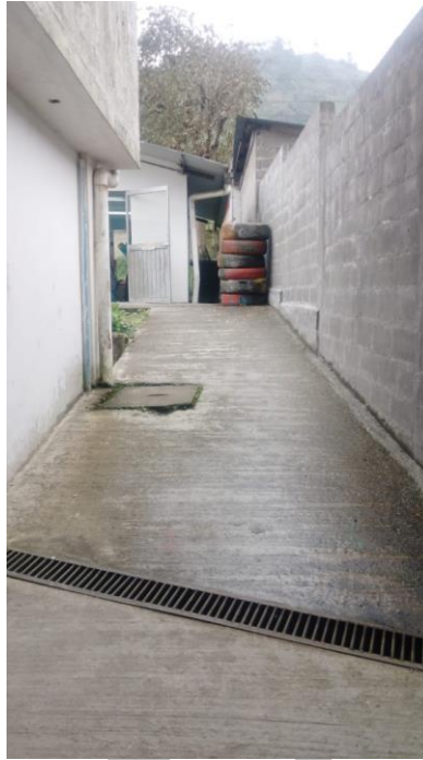
Fotografía 9. Infraestructura para personas de movilidad limitada- Escuela "Manuel Villavicencio".
